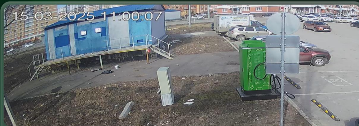
Безопасность трансформаторных подстанций
